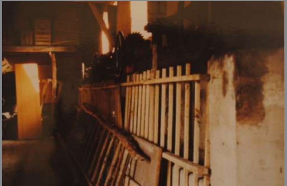
La presa della Roggia Morlana
