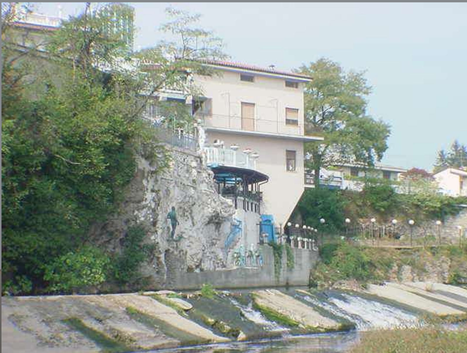
Lo sbarramento dopo il ponte di Gorle
