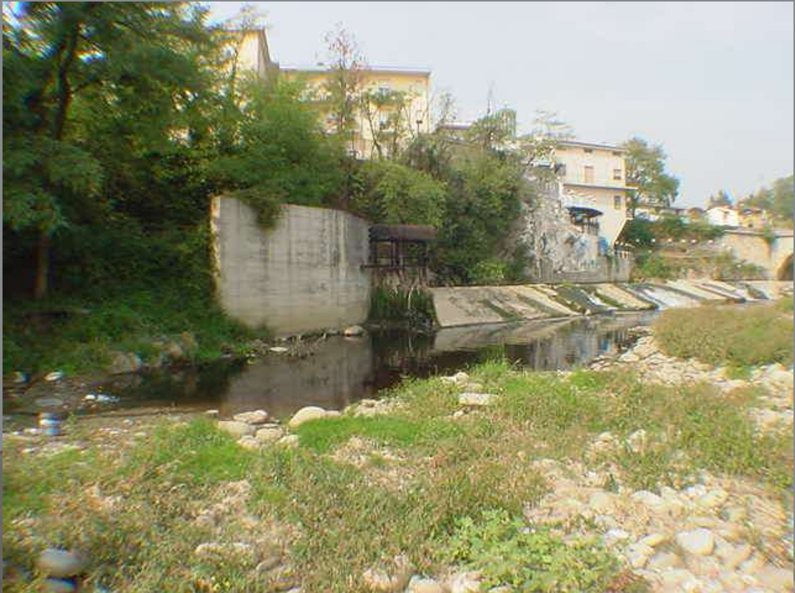
Lo sbarramento e la presa della roggia Ponte Perduto
